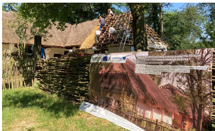
A szalmával való tetőfedést is valóságghűen, közvetlenül a tetőn gyakorolhatták a résztvevők, szigorú biztonsági előírások betartása mellett.
